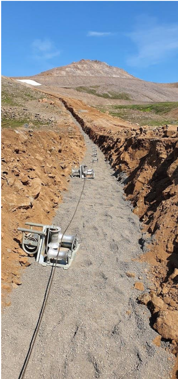
Vopnafjarðarlína 1 (66 kV). Á framkvæmdatíma og ári síðar.
