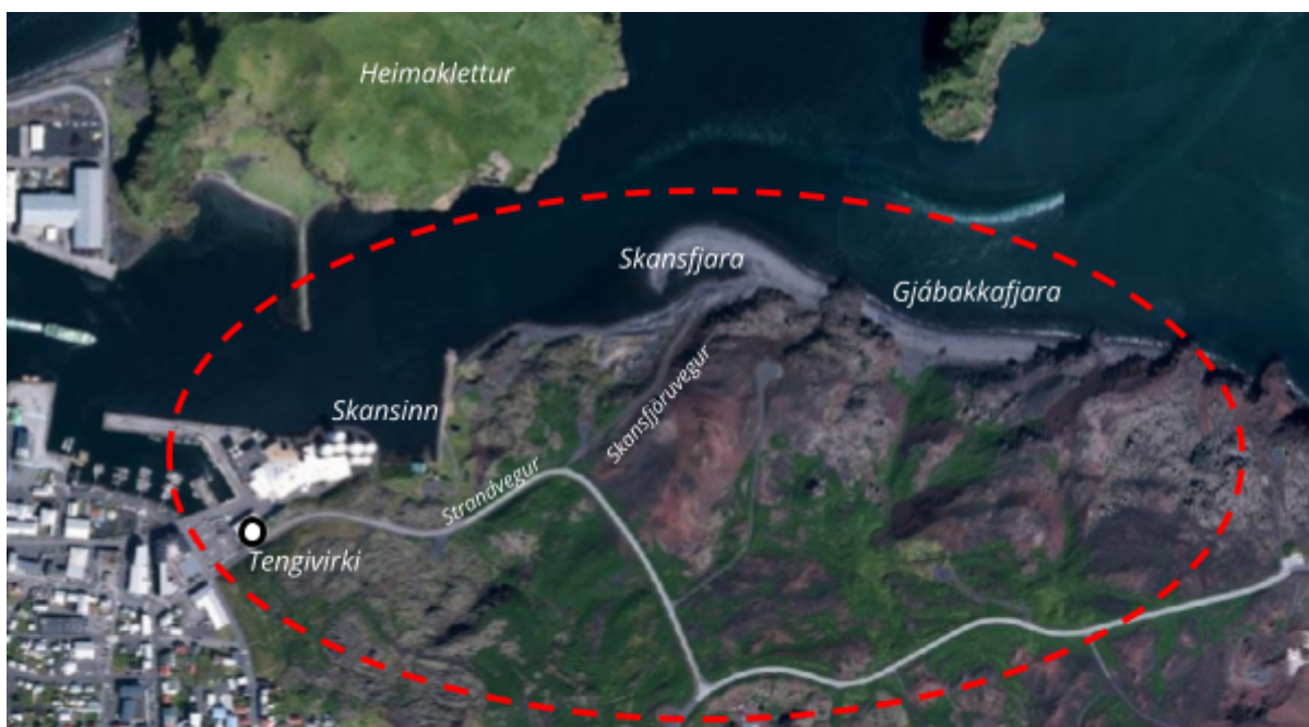
Mynd 1.1: Svæðið sem skipulagsbreytingin varðar er afmarkað með rauðum hring ásamt tengivirki Landsnets.
